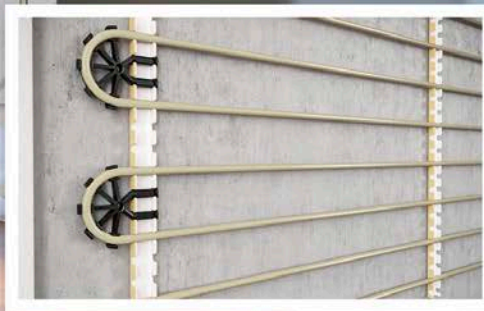
Стеновое отопление - мокрый метод
