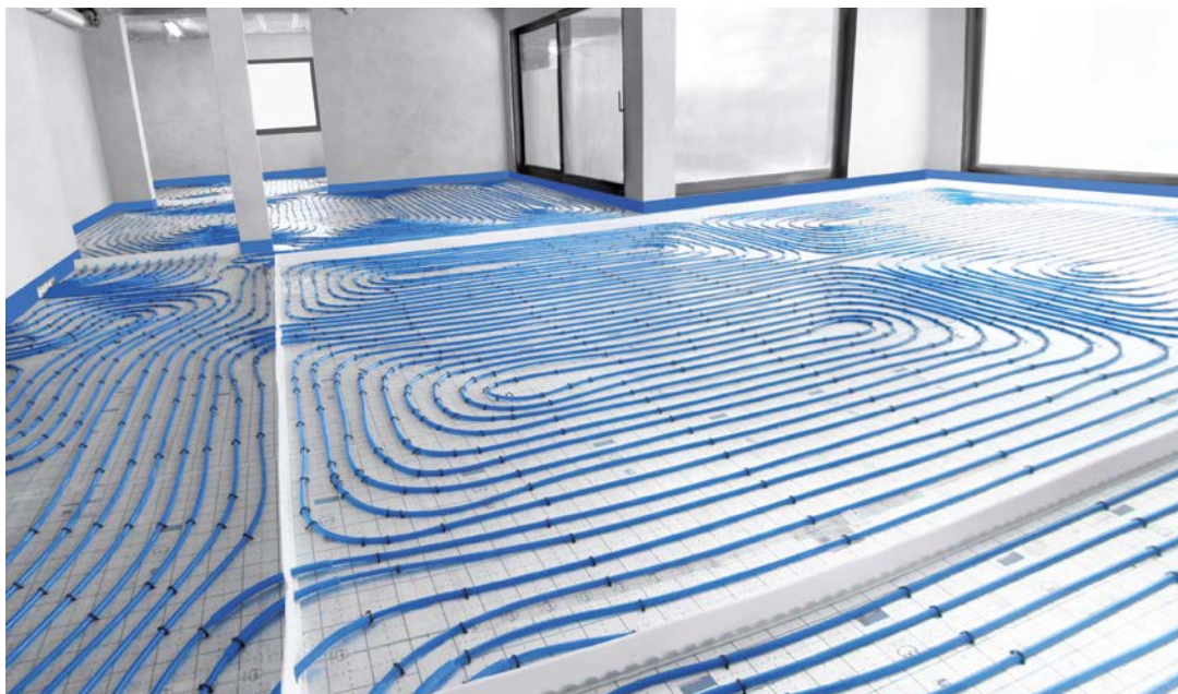
Рис. 24. Подпольное отопление, выполненное в системе KAN-therm Tacker
