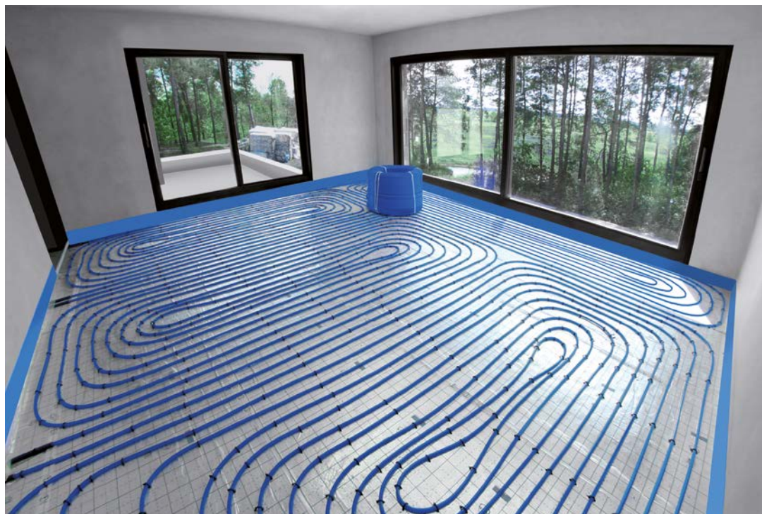
Рис. 3. Система панельного отопления в частном доме при использовании труб PE-RT Blue Floor и системы KAN-therm Tacker.
